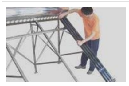
Закріпити кінець трубки в тримачі
